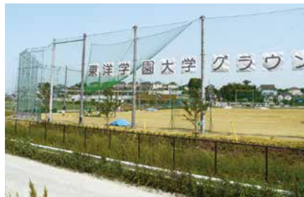
2011年3月、流山に3番目のグラウンドが竣工
