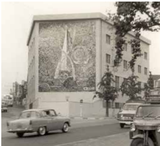
1961年竣工の本郷旧1号館（東洋女子短期大学）
