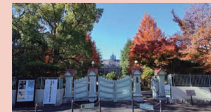
奈良女子大学記念館は修復工事中(11/30)
